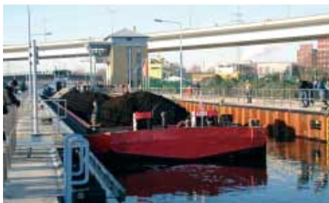
Die Schleuse ist eröffnet – hier ein Schubverband bei der Einfahrt.
