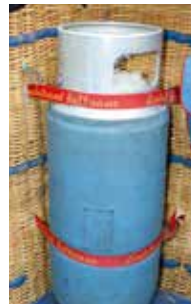
Sichere Befestigung des Gaszylinders
