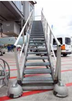
Außentreppe mit Gitterroststufen
