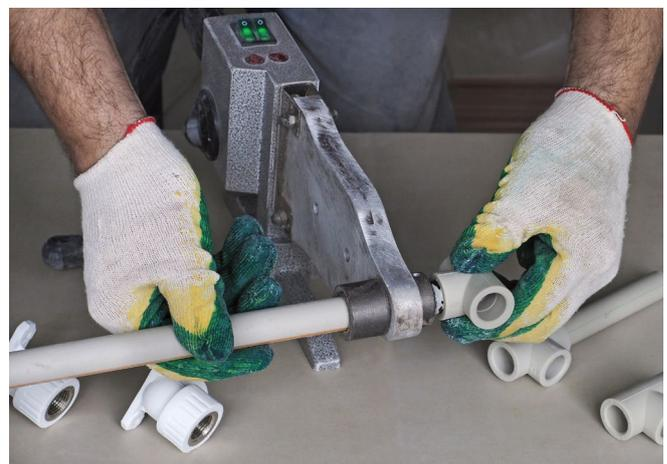
Abb. 34 Heißschweißen von PVC-Rohren
