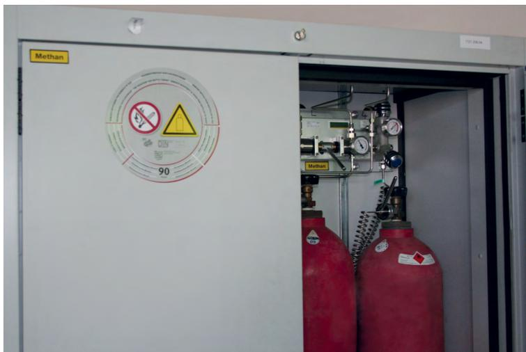
Abbildung 12: Angeschlossene Druckgasflaschen in einem Sicherheitsschrank für Gase
