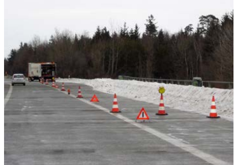
Abb. 13 Absicherung einer Einsatzstelle
