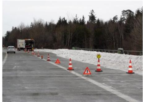
Abb. 13 Absicherung einer Einsatzstelle
