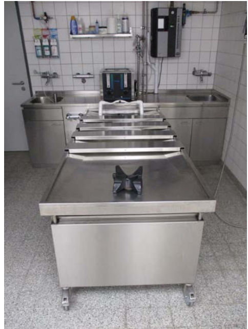
Abb. 8 Der Versorgungs-/Behandlungsraum muss die baulichen Voraussetzungen erfüllen
