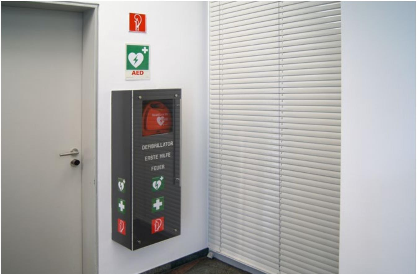
Abb. 2 Wandschrank mit Defibrillator, Erste-Hilfe-Material und Feuerlöscher
