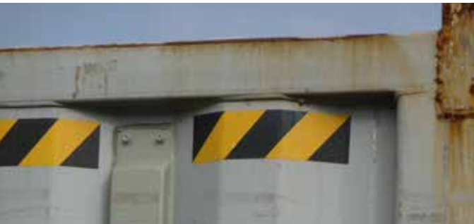
Verklebte Lüftungsschlitze
